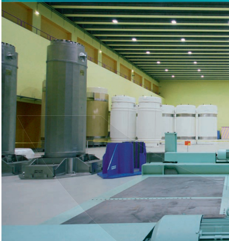
BLICK IN DIE BEHÄLTER-LAGERHALLE
