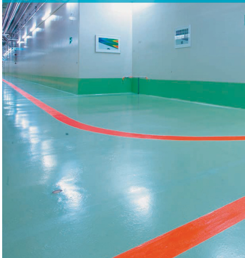
TRANSPORTKANAL ZWISCHEN VERARBEITUNGSANLAGEN UND LAGERGEBÄUDEN
